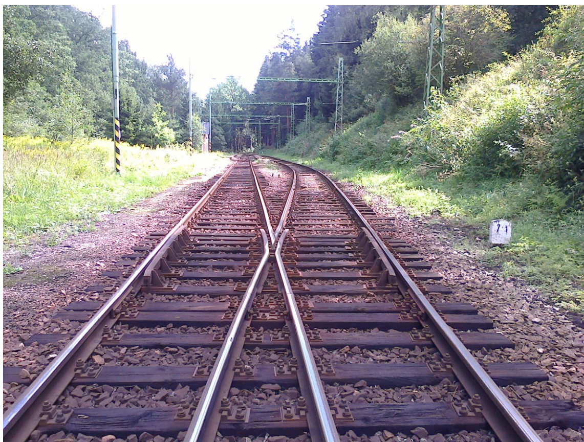
Foto č. 5 a 6: TSO výhybky č. 2SV v dopravě Rožmberk n./Vlt.
